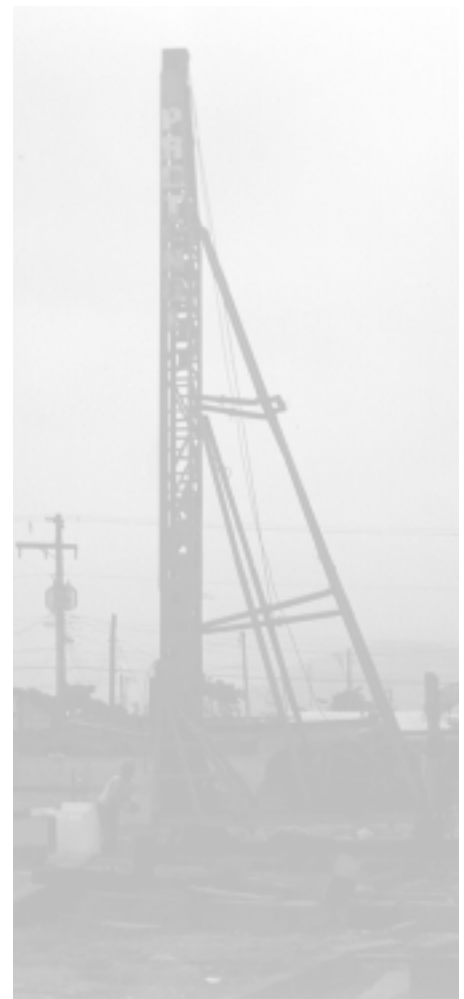
Estaqueamento da área foi concluído
