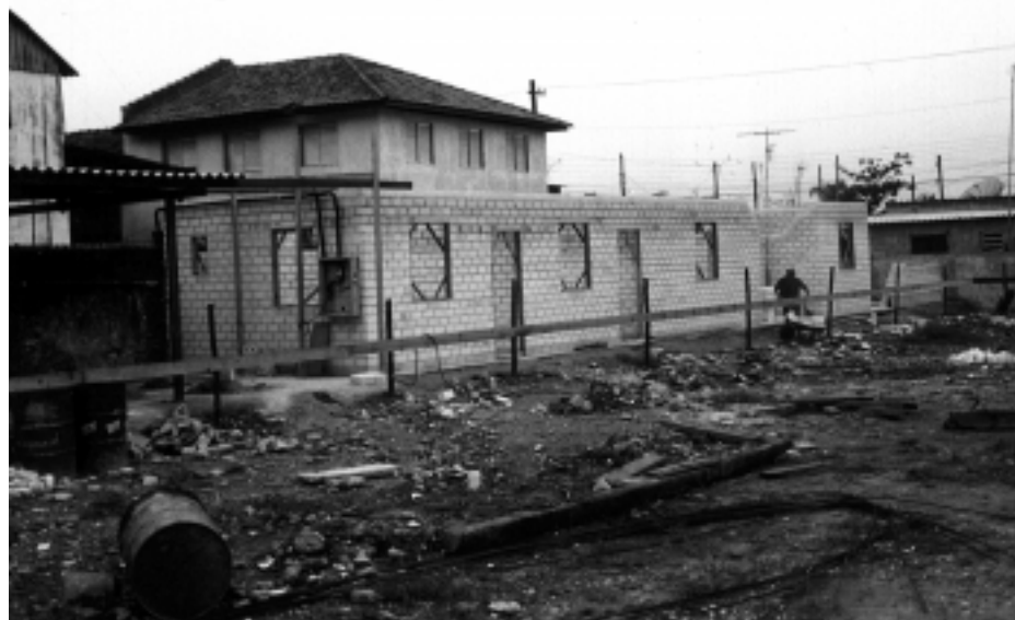
Canteiro em fase de construção.
